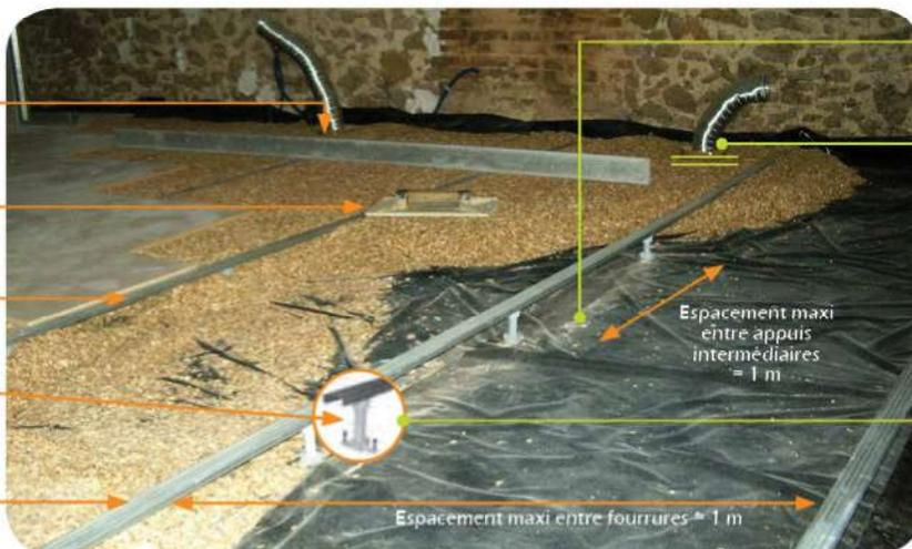
A noter : Les gaines et canalisations sans soudure ni raccord peuvent être noyées dans le GRANULAND ISOL. L'épaisseur de la couche doit être comprise entre 2 cm et 20 cm. Pour cas particuliers, nous contacter.
